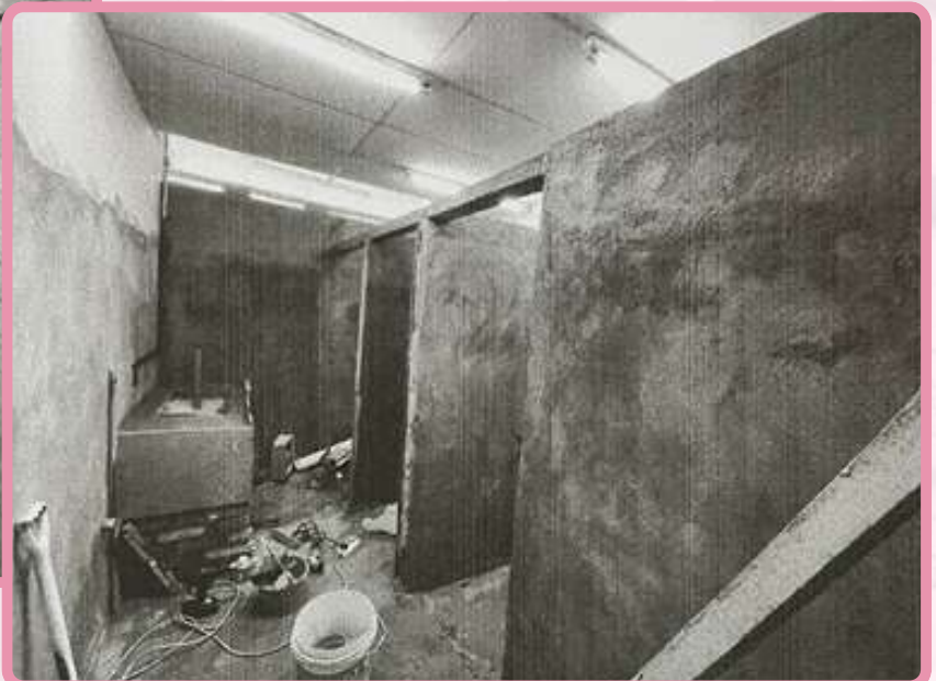
Proses penggantian jubin pada lantai dan dinding tandas
