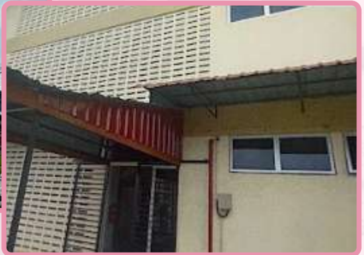
Kerja-kerja pemasangan awning
