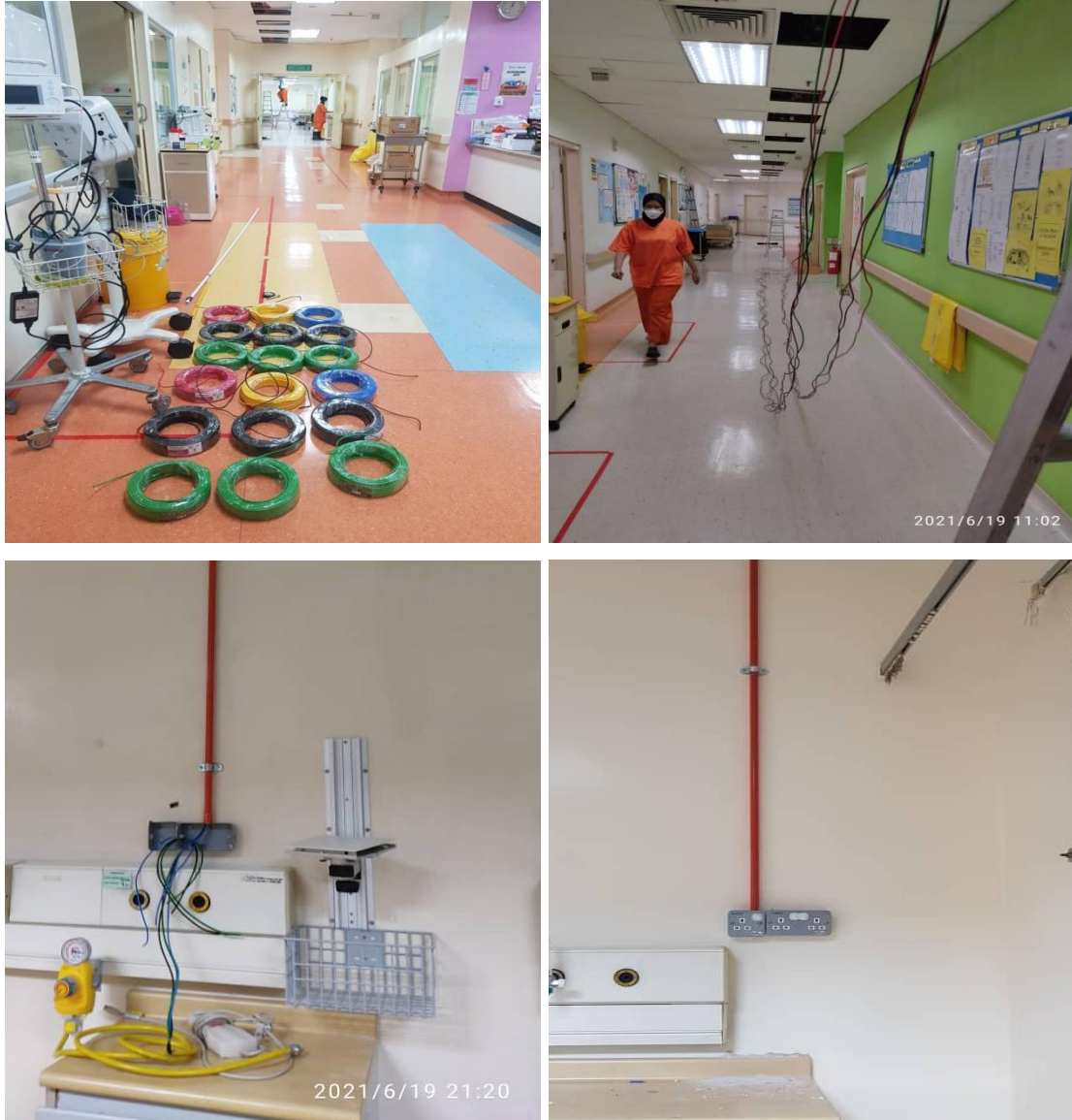
Gambar rajah 2: Kerja-kerja pemasangan soket di Hospital Sungai Buloh
