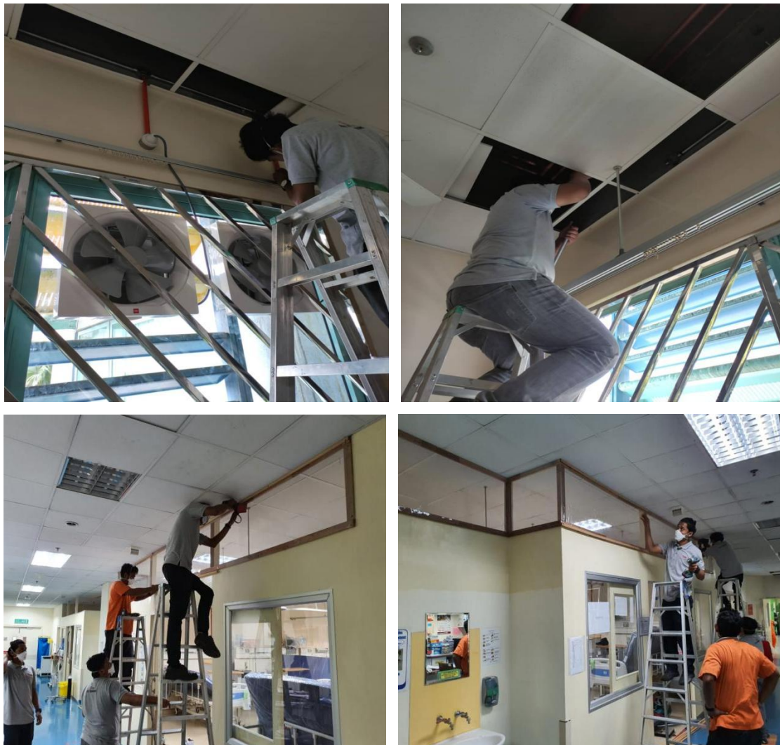
Gambar rajah 3: Kerja-kerja pemasangan kipas pelawas di Hospital Sungai Buloh
