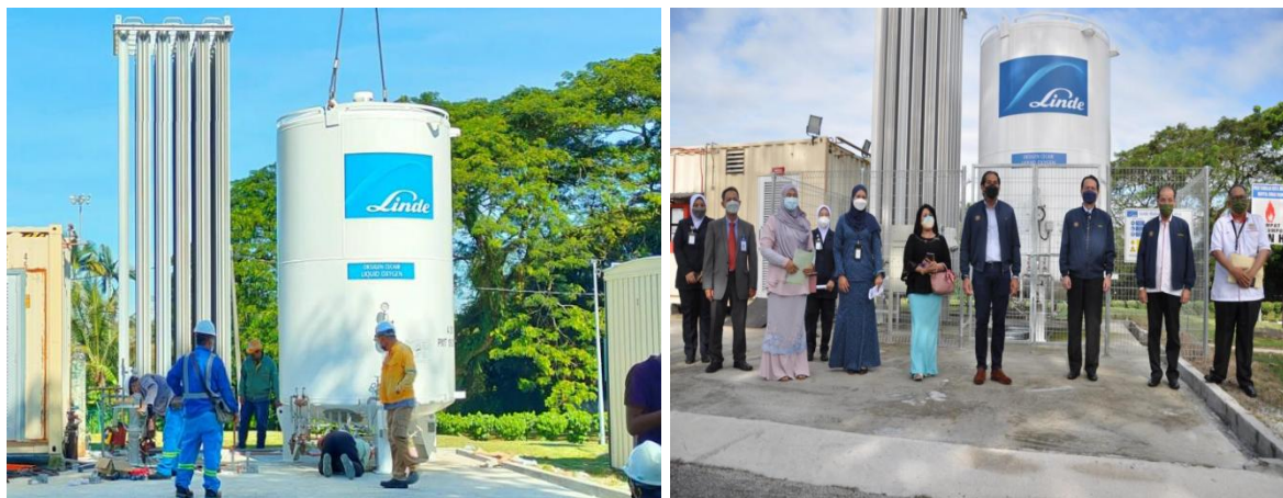
Gambar rajah 4: Pemasangan tangki VIE di PKKN
