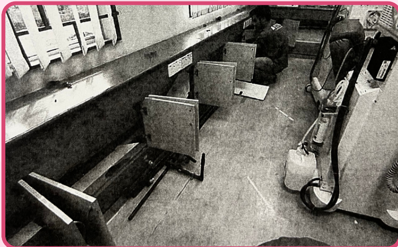
Kerja-kerja penggantian paip jenis ABS ke pex pipe
