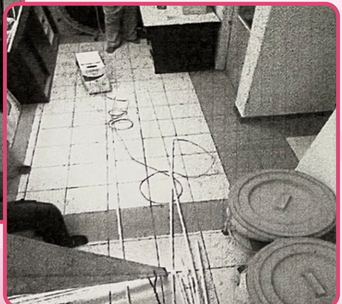
Kerja-kerja pemasangan kabel Cat 6
