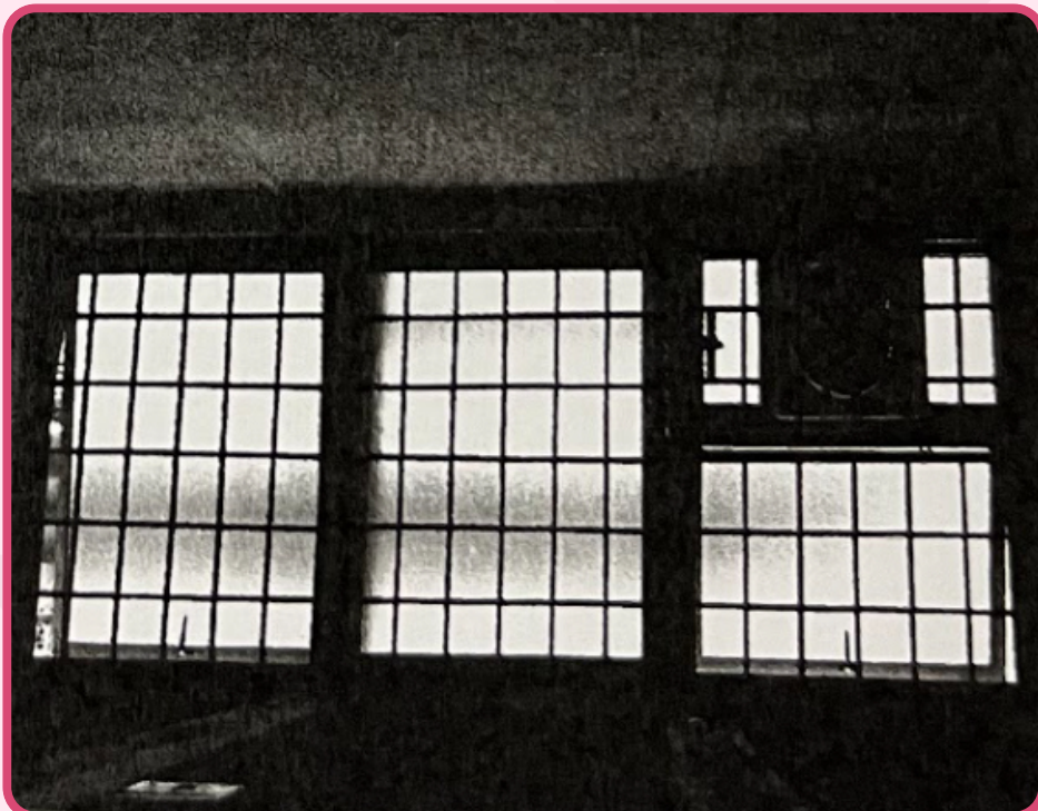
Pemasangan grill pada tingkap tandas Wad 2
