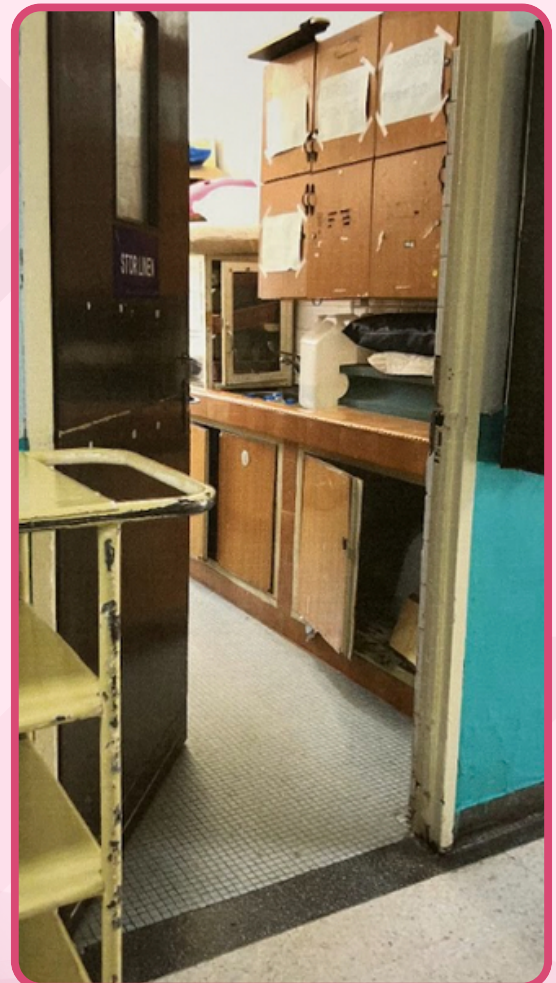
Gambar sebelum kerja-kerja naik taraf
