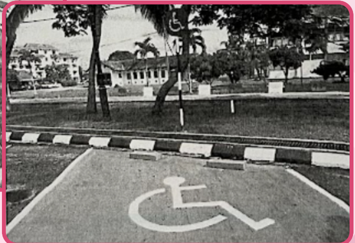
Kerja-kerja membina line parkir kenderaan
