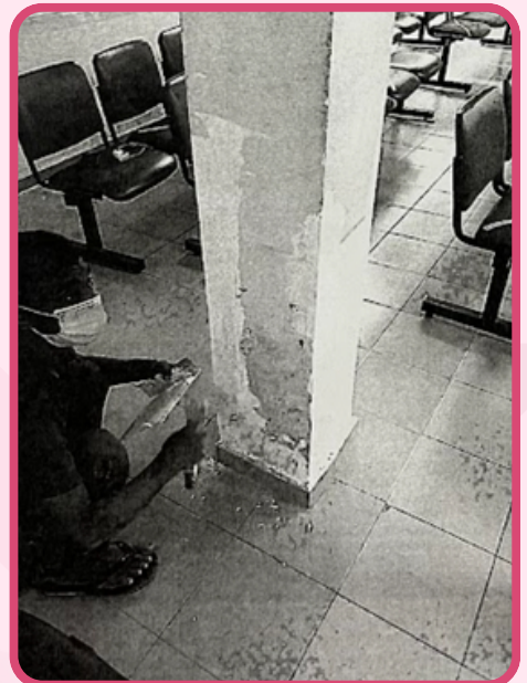
Kerja-kerja mengecat ruang hadapan kaunter menunggu
