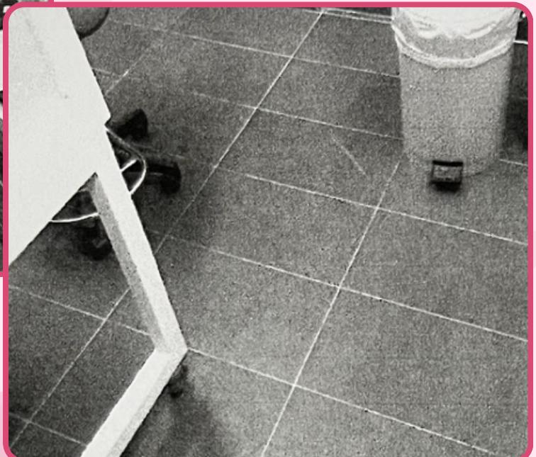
Pemasangan tile lantai baru
