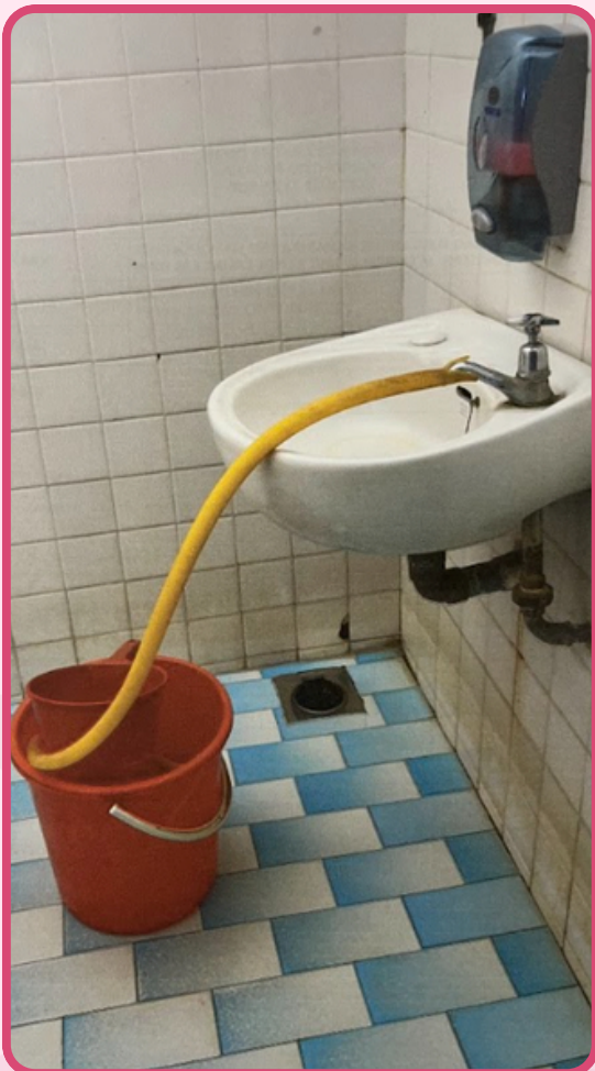
Gambar sebelum kerja-kerja naik taraf
